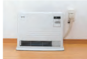
温水ルームヒーター設置状態。
